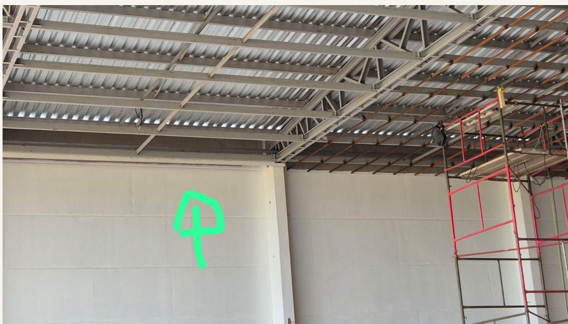
Fotografia 64 — Parede interna e estrutura da cobertura durante a obra, com marcação em verde sobre a placa de fechamento.
