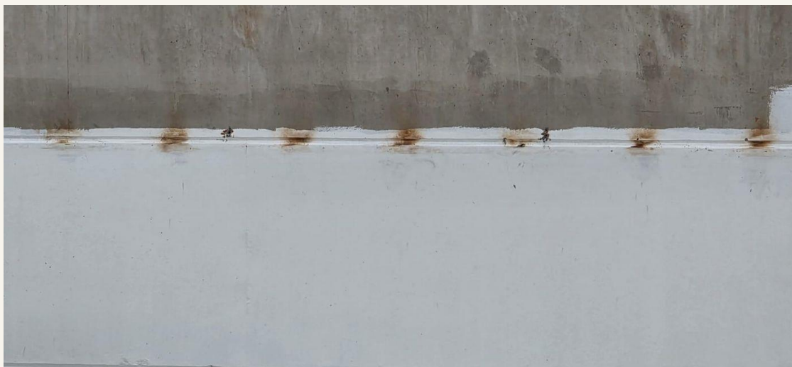
Fotografia 32 — Passo regular dos pontos arrancados ao longo da junta.
