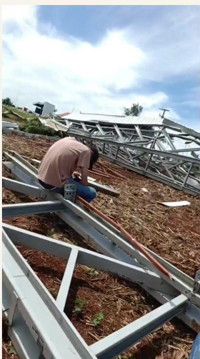
Fotografia 104 — Banzo de tesoura em primeiro plano, com pequena chapa de ligação furada, sobre o terreno.
