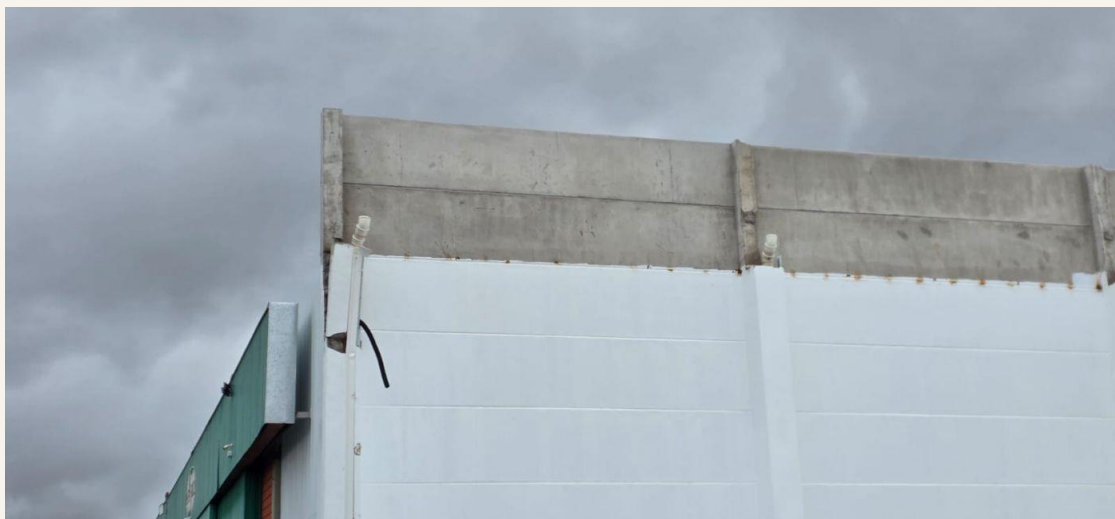
Fotografia 10 — Topo do fechamento: placa de platibanda em concreto aparente sobre as placas pintadas.
