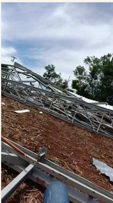
Fotografia 103 — Segundo vídeo: tesouras tombadas formando um amontoado inclinado, com telhas brancas presas ao alto.
