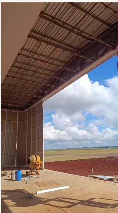
Fotografia 61 — Quadro de vídeo: o interior visto em direção ao vão do portão, com a estrutura da cobertura aparente na faixa frontal e as folhas recolhidas junto à parede lateral.
