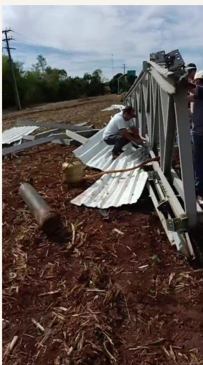
Fotografia 102 — Trecho de tesoura de pé sobre o terreno, com os suportes de terço no topo, cilindros de corte ao lado; ao fundo, linha de postes e placa de rodovia.
