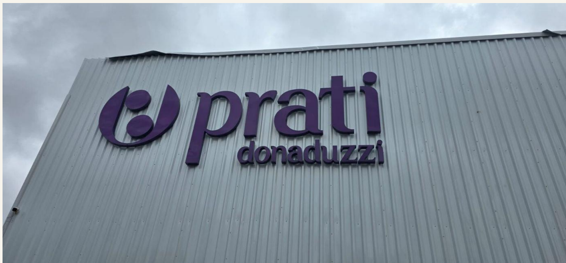
Fotografia 06 — Fachada do hangar em telha trapezoidal, com a identificação visual da contratante.
