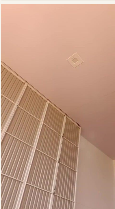
Fotografia 62 — Quadro do mesmo vídeo: o forro liso encontra as folhas do portão recolhidas, com quadro metálico e preenchimento em chapa trapezoidal.
