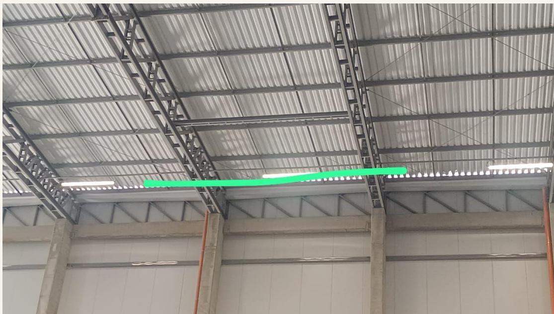
Fotografia 65 — Topo da parede lateral visto de dentro, com traço verde de terceiro ao longo da linha em que a luz passa entre as ondas da telha.
