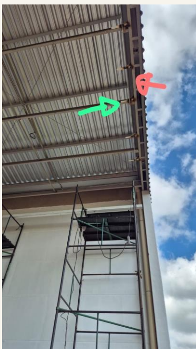
Fotografia 68 — Beiral da cobertura visto de baixo, pelo lado externo, com setas de terceiro sobre os suportes junto à borda.
