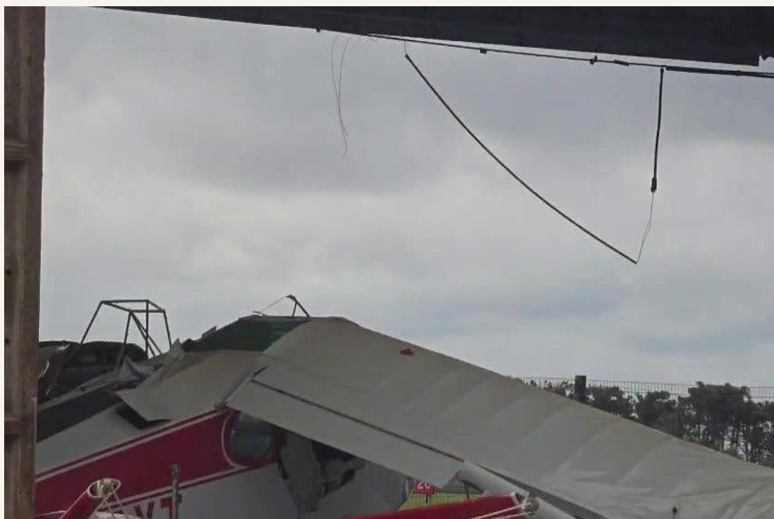
Fotografia 58 — Aeronave de pequeno porte destruída sob os destroços da cobertura do hangar vizinho. Quadro extraído do mesmo vídeo da Fotografia 57, recebido em 11/10/2026.
