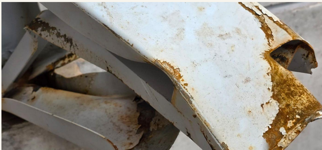
Fotografia 17 — Aproximação da ruptura da Fotografia 16.
