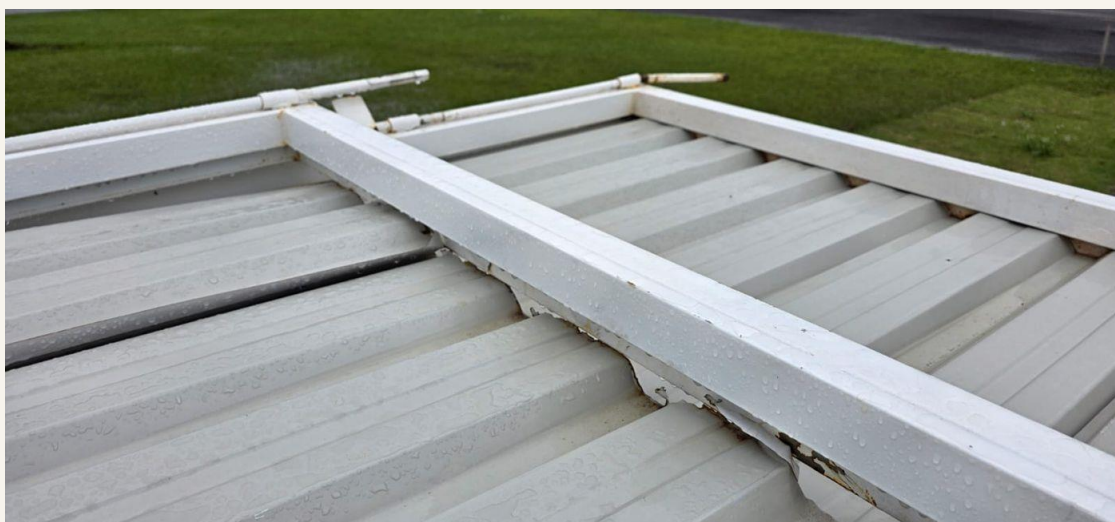
Fotografia 76 — Folha do portão vista de cima: quadro e travessas retos; chapa descolada da travessa central; pinos-guia salientes na borda superior.
