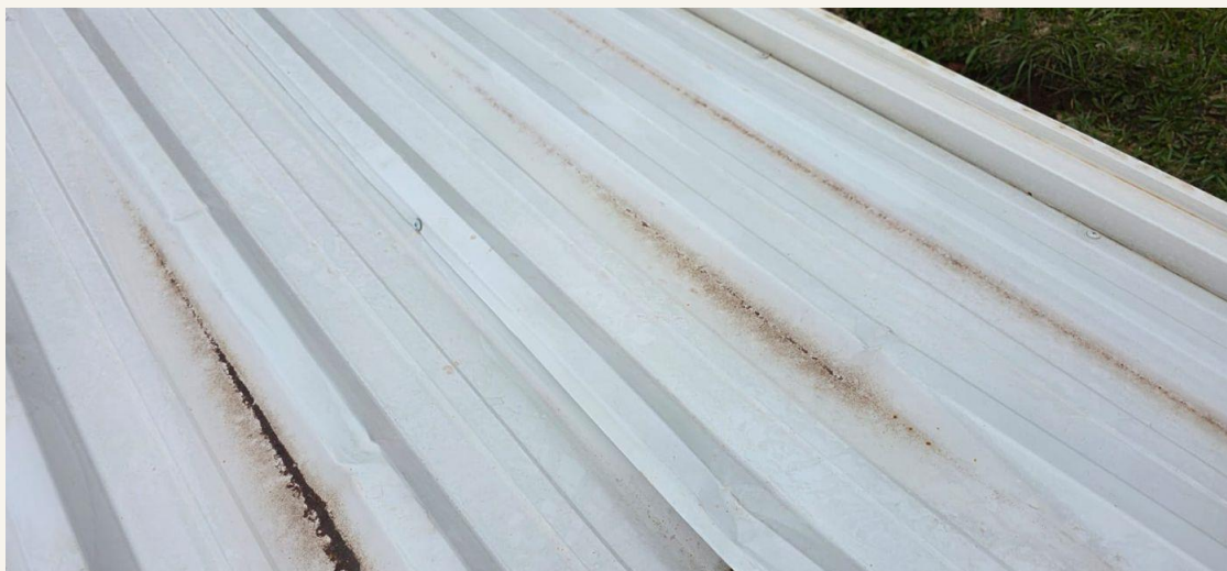
Fotografia 83 — Chapa trapezoidal de folha do portão com faixas de oxidação ao longo das ondas, sobre o gramado.
