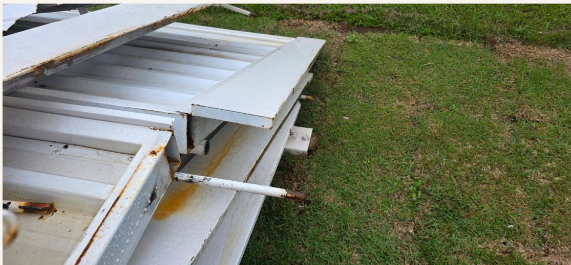
Fotografia 79 — Folhas empilhadas sobre o gramado: pino-guia dobrado e escorrimento de oxidação no quadro.
