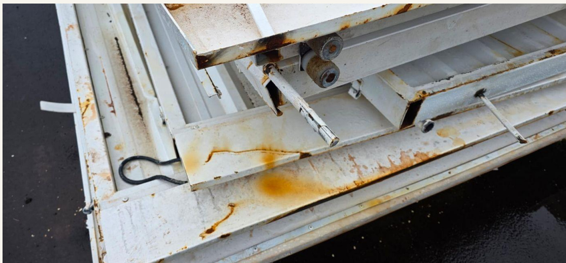
Fotografia 77 — Roldanas e pinos-guia na extremidade de folhas empilhadas no pátio, com escorrimentos de oxidação na pintura.
