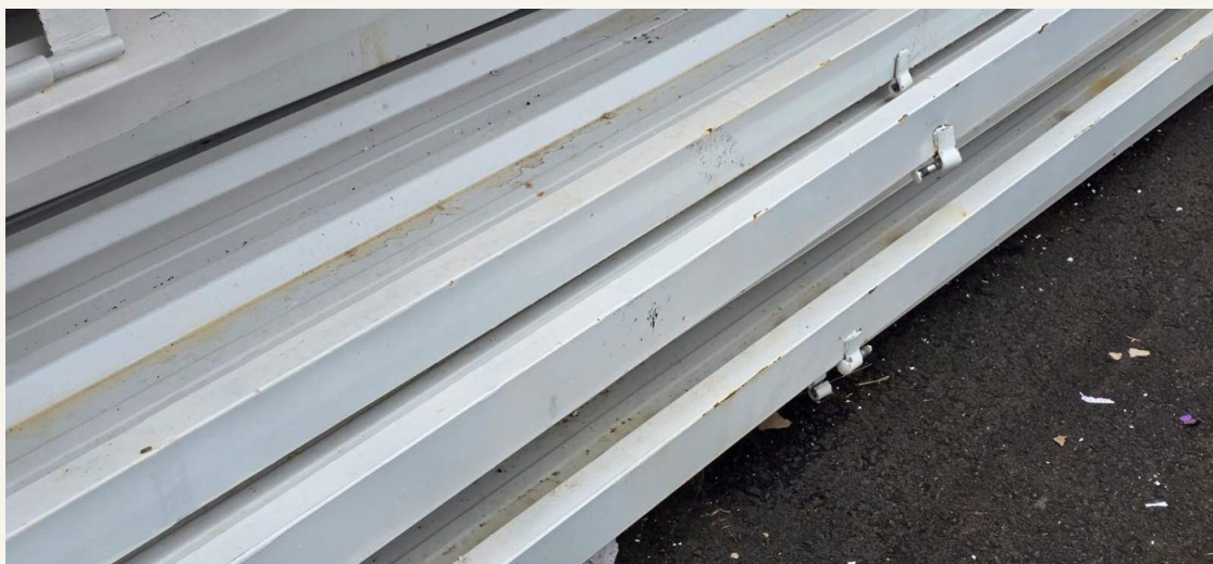
Fotografia 41 — Perfis do quadro das folhas, empilhados sobre o pavimento.
